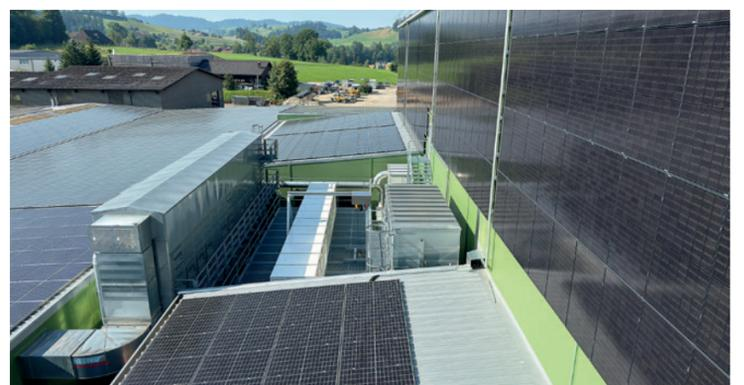
Der Batteriespeicher (Bildmitte) kann überschüssigen Solarstrom zwischenspeichern und bei Bedarf wieder an das Netz abgeben.
